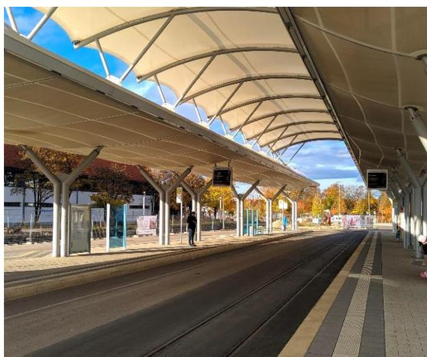
Abbildung 34: Der neue ZOB mit weißem Dach zum verbesserten Albedo-Effekt; GreenAdapt, eigene Aufnahmen 2020.
